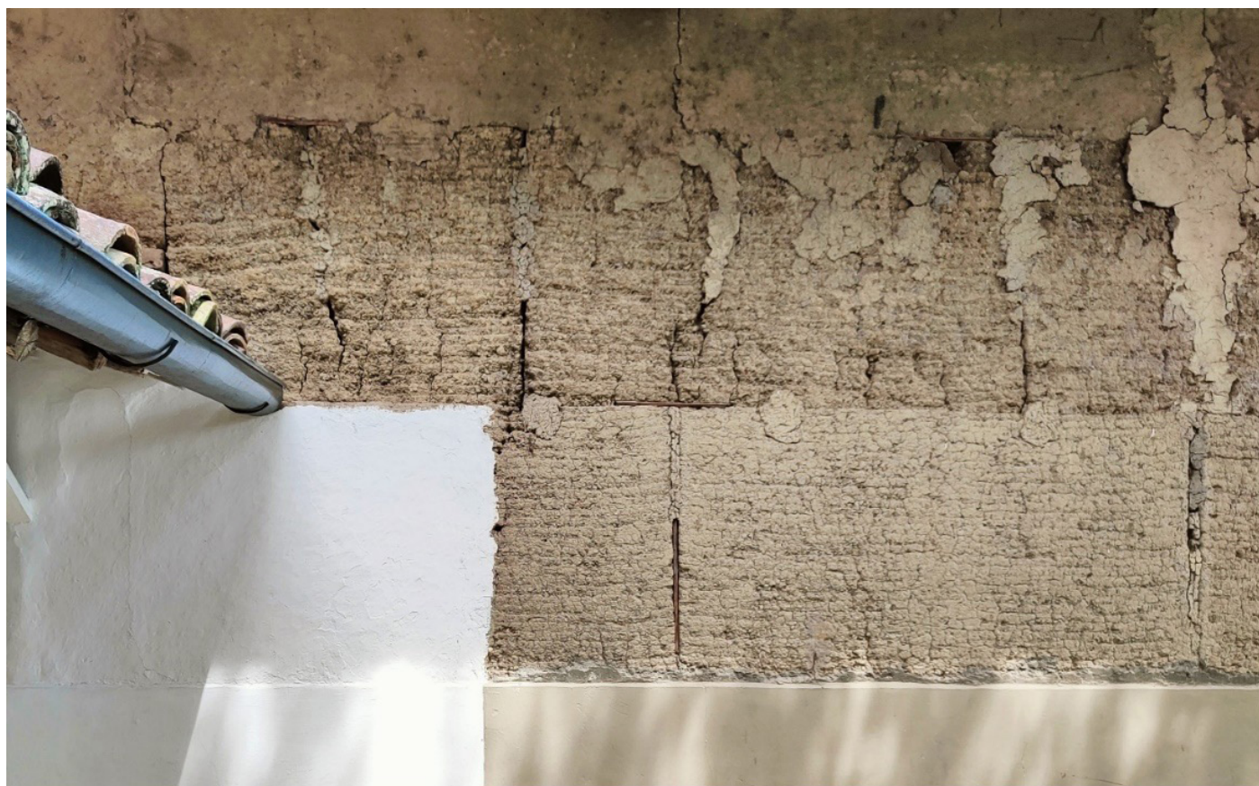
Muro de tapia en vivienda en la ciudad de Cartago, Colombia. Imagen propia.
