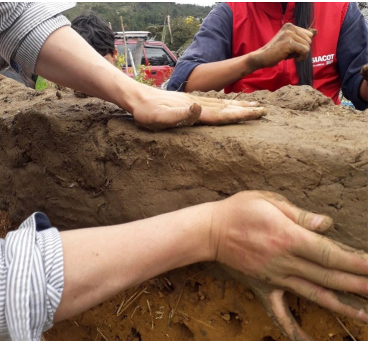
Construcción comunitaria con cob. Imagen propia.
