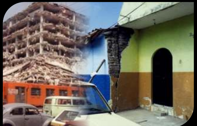
Figura1. Daños provocados por temblores en el estado de Colima y en la Ciudad de México
