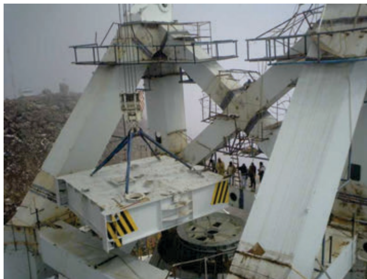
Una vista del proceso de construcción del GTM.
