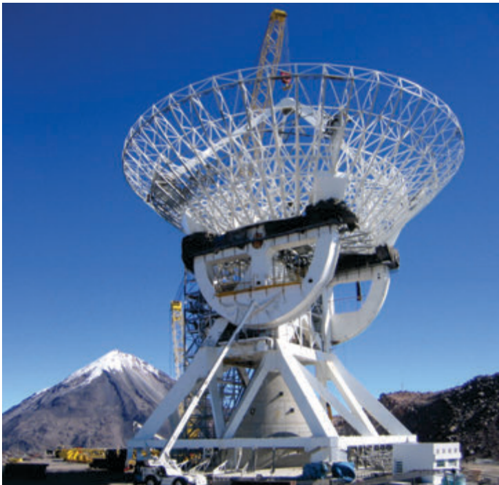
Vista de construcción del GTM.
